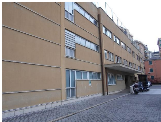
Figura 0.1 - Vista della facciata esposta a Sud-Est
