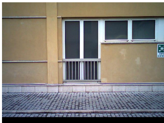
Figura 4.7 – Rilievo termografico dei serramenti
