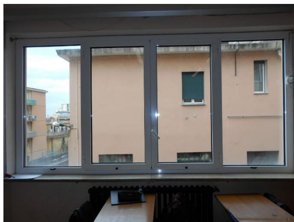
Figura 4.5 - Particolare dei serramenti
