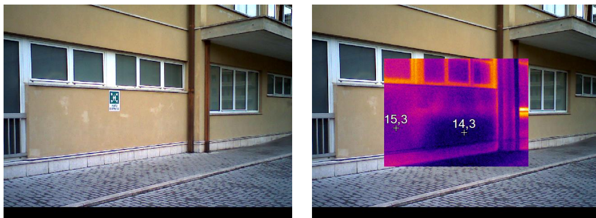
Figura 4.3 – Rilievo termografico della parete
