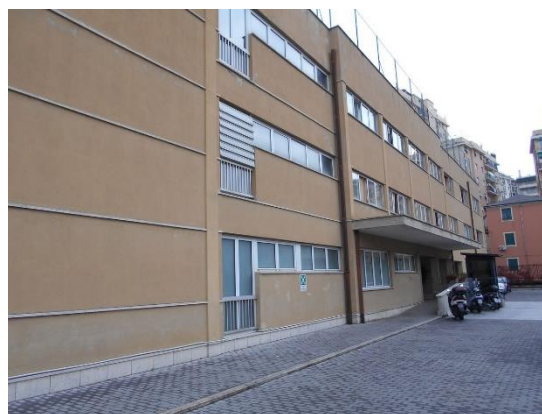
Figura 8.1 - Particolare di una parete esterna
