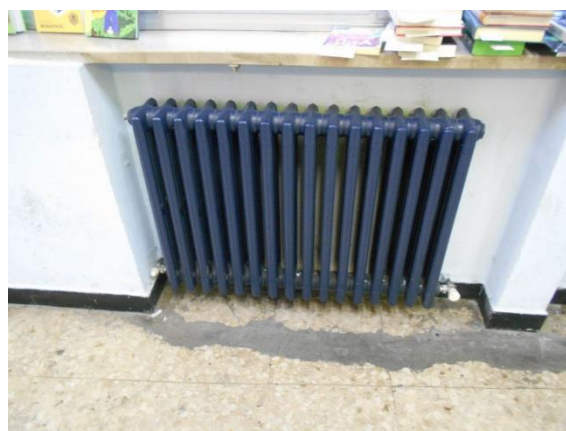
Figura 4.8 - Particolare di un radiatore in ghisa
